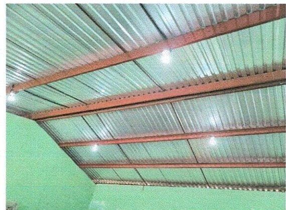
Foto 8: Mejoramiento de techo
