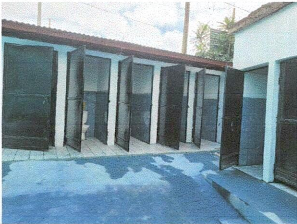
Foto 4: Mejoramiento de área de servicios sanitarios
