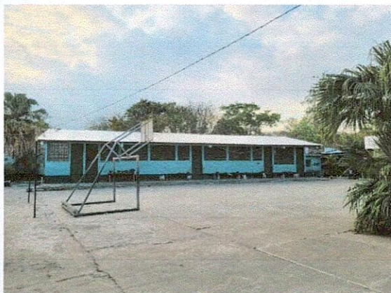
Foto 7: Mejoramiento de techo
