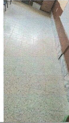
Foto 2: Mejoramiento instalación de piso
