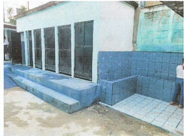
Foto 5: Mejoramiento de área de servicios sanitarios
